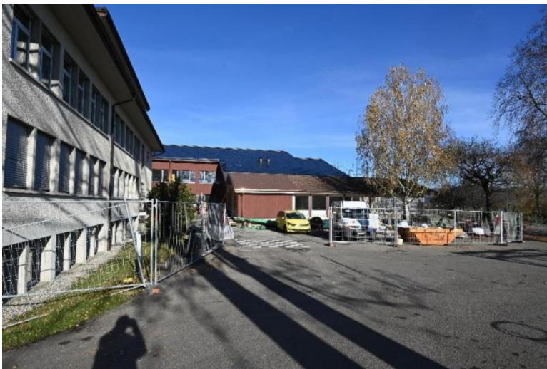
Schulhaus Gerzensee, Sanierung MZG 2024
